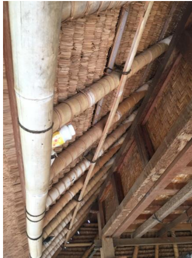
Gambar 4. Struktur Atap Bangunan Paon Sumber: Observasi Lapangan, 2019
