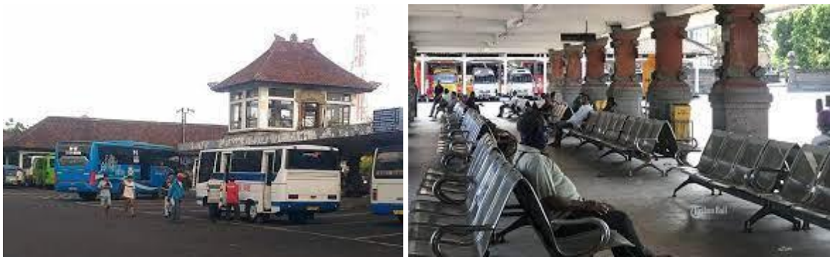
Gambar 1 Kondisi Gedung Terminal Ubung Sumber: Dokumentasi Pribadi, 2021
